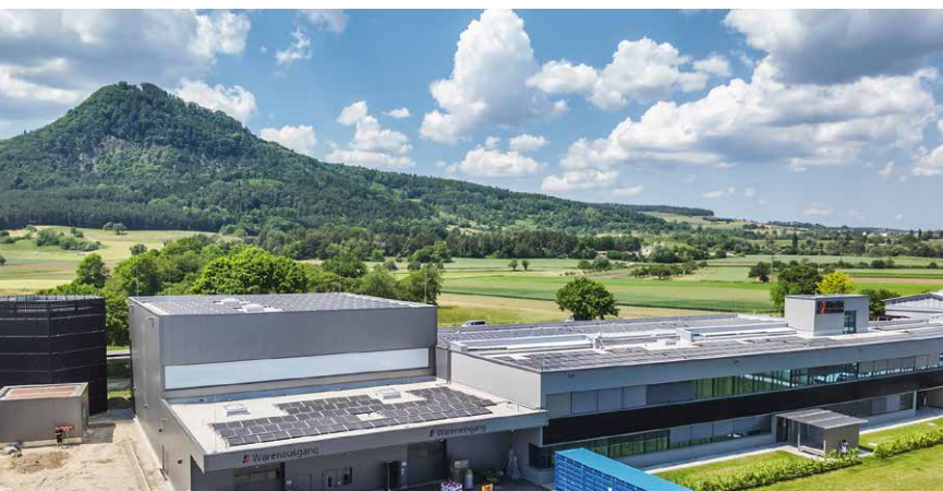
Der Solarkomplex-Kunde StandexMeder Electronics GmbH deckt dank „Solarstrom direkt“ mehr als die Hälfte seines Strombedarfs regenerativ.
