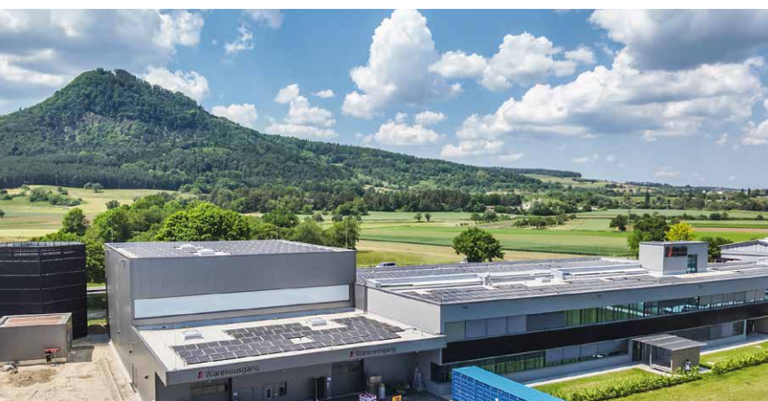
Der Solarkomplex-Kunde StandexMeder Electronics GmbH deckt dank „Solarstrom direkt“ mehr als die Hälfte seines Strombedarfs regenerativ.
